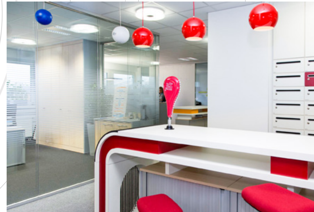
Glaswand doppelt verglast und foliert
